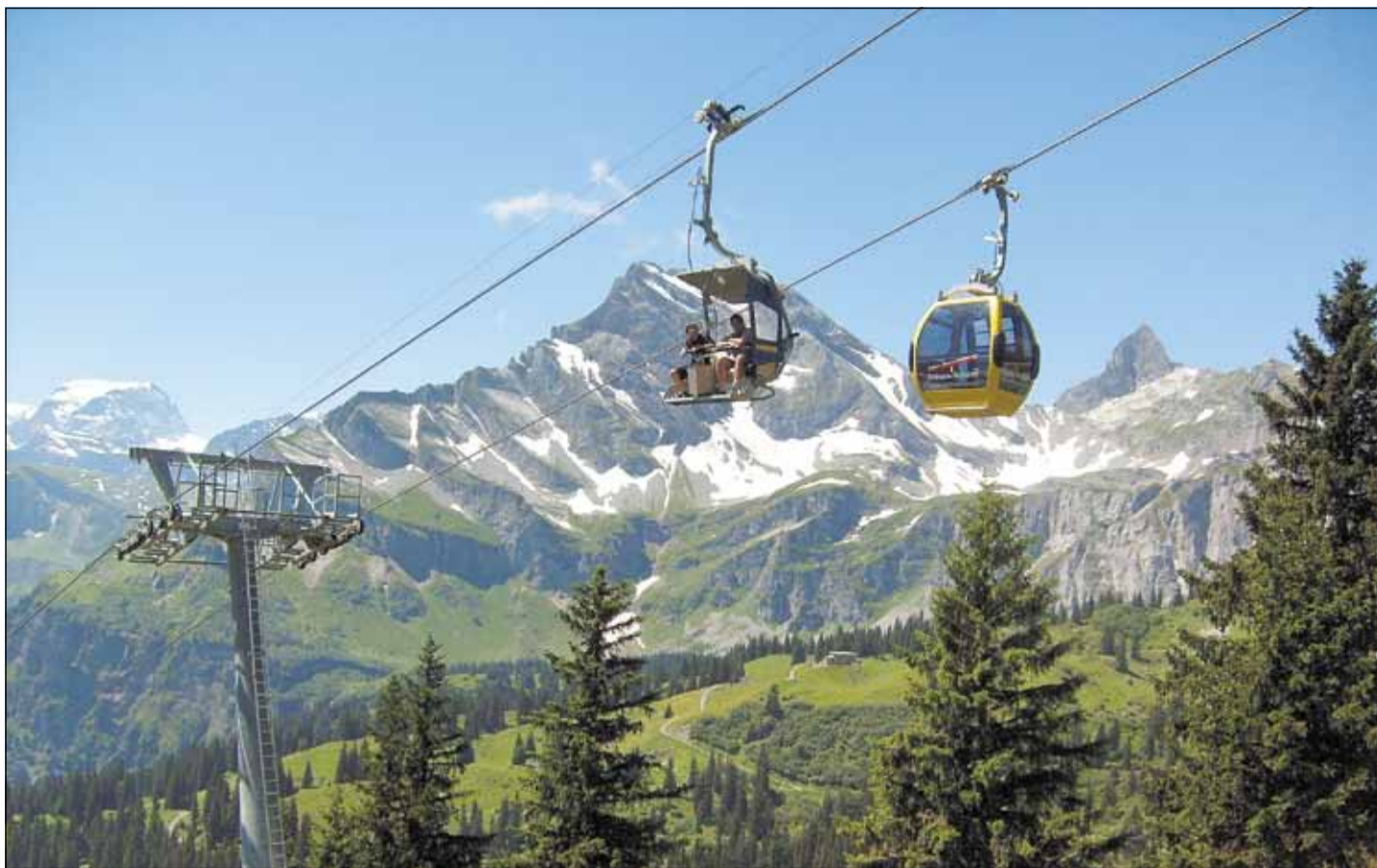
Die modernisierte Sesselbahn «Gume» in Braunwald setzt auf eine Kombination aus Quersesseln und Viererkabinen.
